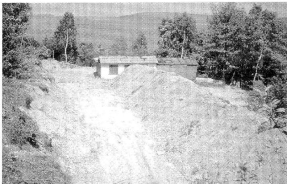
Für die neue 50 m Kleinkaliber-Schießanlage und den Schützenhausanbau sind Ausschachtungsarbeiten durchgeführt worden.
